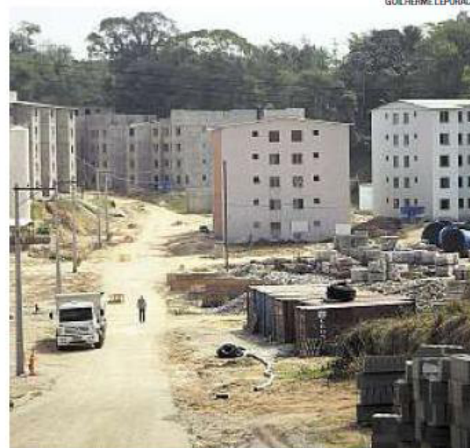
Sem previsão. O Conjunto Zilda Arns: obra sem prazo para ser concluída
