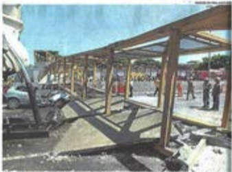
Impacto de 100 toneladas. Para os engenheiros, não havia como a estrutura resistir
