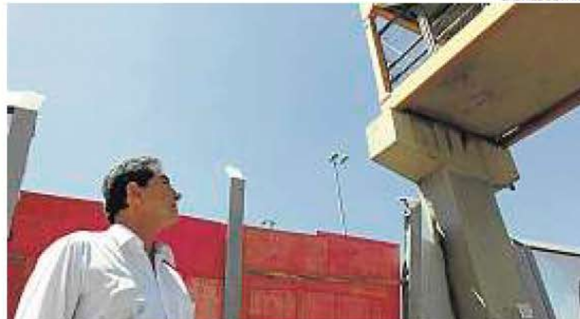
Estrutura. Engenheiro Jaques Sherique observa pedaço intacto da passarela
