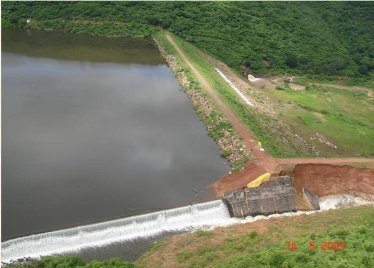
13 Maio 2009: saturação solo, atoleiros; construção manual (aterro e enrocamento) proteção a montante barragem,
