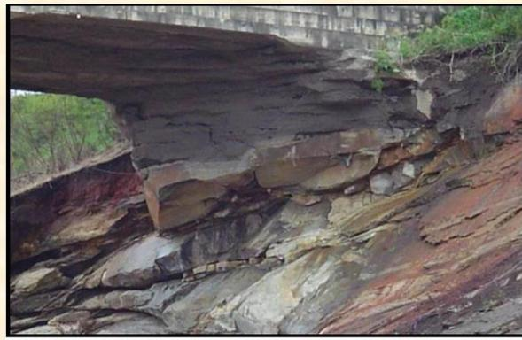
Figura 6.13 – Barragem assente sobre blocos praticamente soltos
