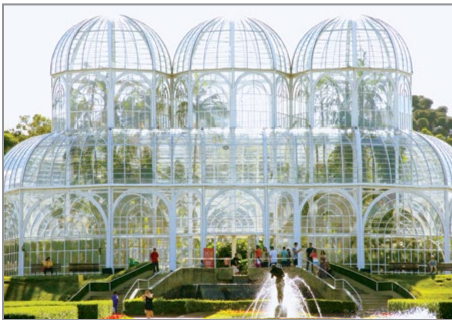
Em Curitiba, Paraná, 100% dos prédios públicos são integrados por fibra óptica
