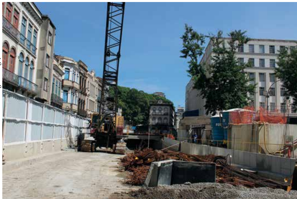
Obras na Rua Primeiro de Março para a construção da entrada do Túnel do Binário no sentido Rodoviária. O túnel segue até a Rua Antonio Lages.
