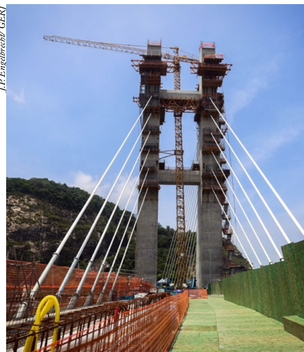
Obras da ponte estaiada em 2015
