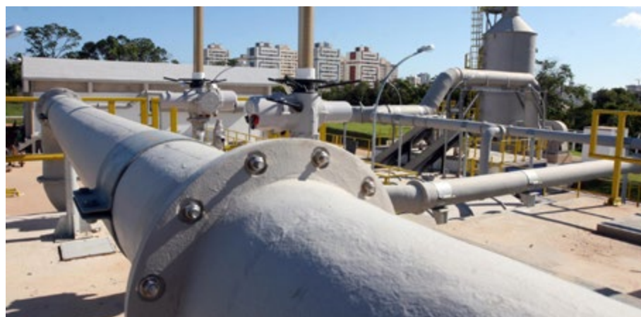
Obras do emissário submarino Sistema de Disposição Oceânica do Jaguaribe, em Salvador (BA)
