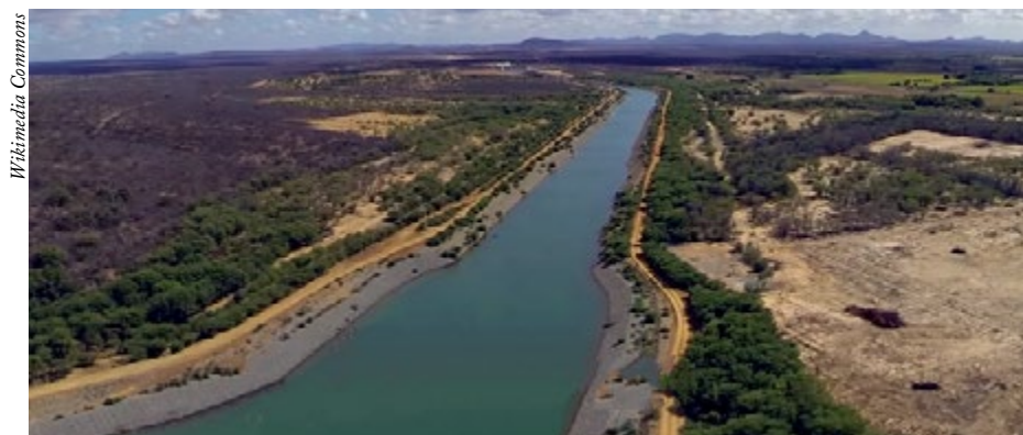
Obras de transposição do São Francisco em 2015, na cidade de Cabrobó (PE)
